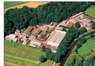
Производственный завод в г.Костелец над Орлицы
