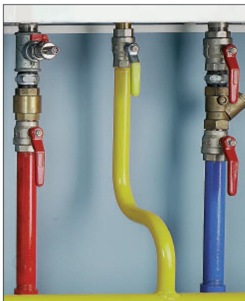
Присоединительная арматура котла к каскаду. В модульной котельной под каждым аппаратом должен устанавливаться обратный клапан и фильтр
