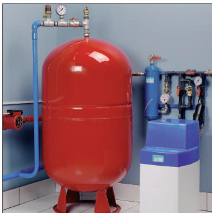
Расширительный бак, автоматическая химводоочистка, работающая без обслуживающего персонала
