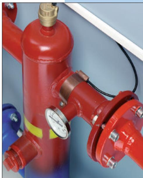
Системный датчик. Установка системного датчика на выходном патрубке по центру оси трубопровода
