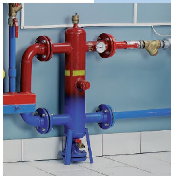
Гидровыравниватель. Служит для выравнивания разности расходов воды в контуре аппарата по отношению к контуру отопления.
